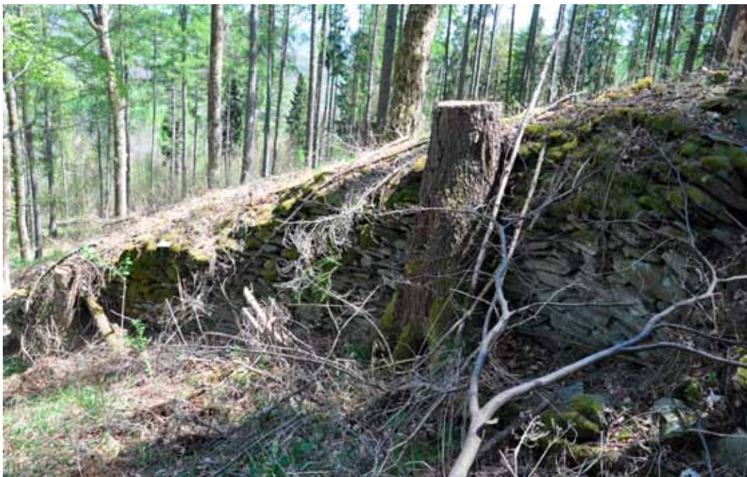
• Obr. 22 – K. ú. Dlouhá Voda, m. č. obce Město Albrechtice (okr. Bruntál). Vhodně ponechaný pařez stabilizující skládanou kamenici. Foto: T. Nitra 2021.
